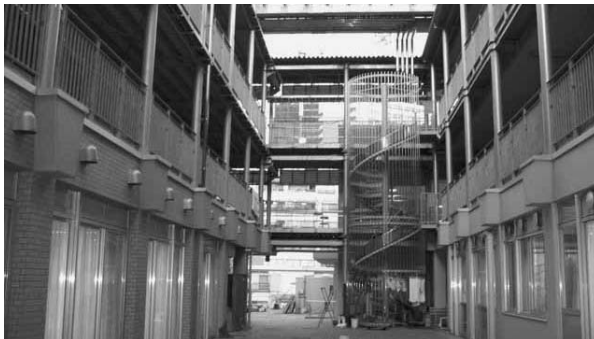
ふれあい広場 既存の学校を改築した部分（左側）と増設された部分（右側）
