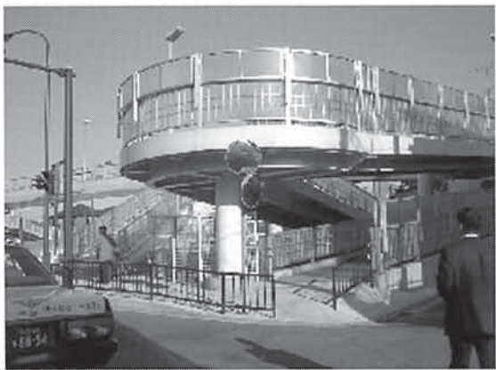
歩道橋には事故防止のためのミラーと防護柵の設置
