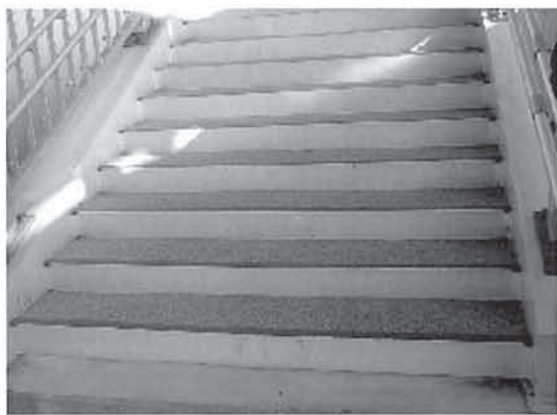
階段にはゴムチップ舗装 段鼻に注意喚起の配色
