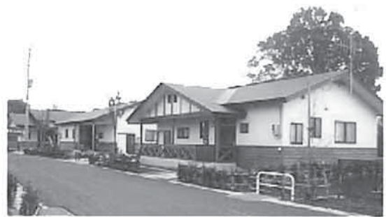
改築後の町営住宅「高野尻団地」
