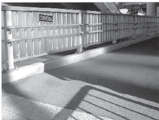
スロープ面のゴムチップ舗装 使いやすい二段手すり
