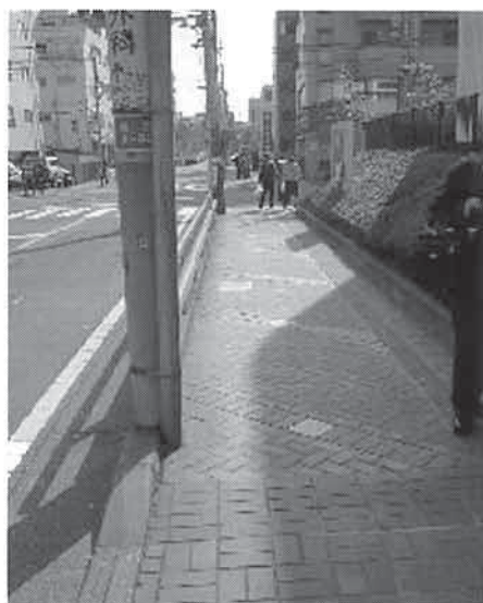
縁石上に電柱等を設置し有効幅員を確保
