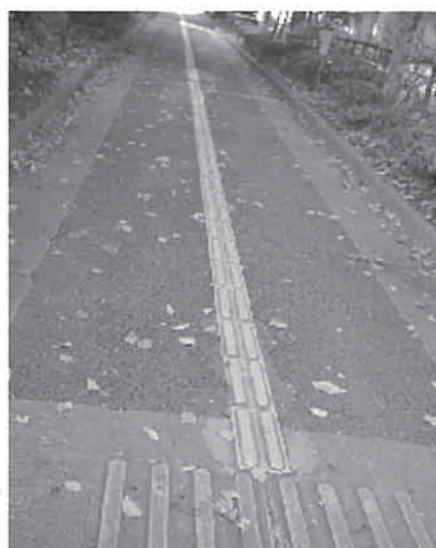
幅員の狭い歩道で誘導ブロックを工夫
