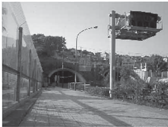
幅員の歩道と透明アクリルの防音壁
