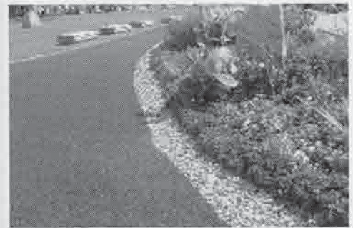
砂利側溝で色調と足の感触で何かあることを知らせる
