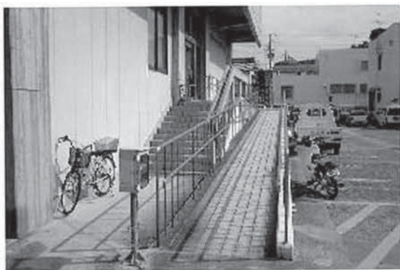
図 5 - 1 二段手すりが 設置されている例
