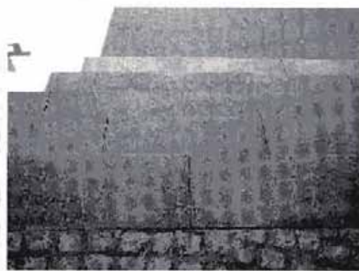
図8-2 段鼻がわかりにくい例
