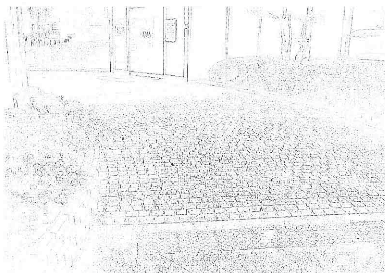
図2 スロープの仕上げがガタガタで車椅子では通れない例
