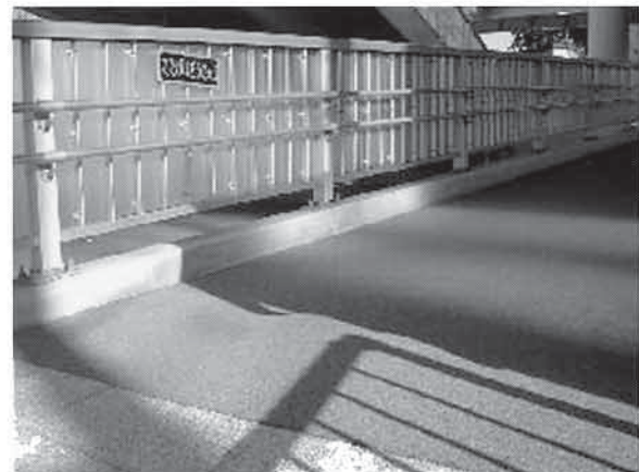
図15 スロープ面も平坦部と色を変えゴムチップ舗装、二段手すりを設置 (横浜市笹下歩道橋)
