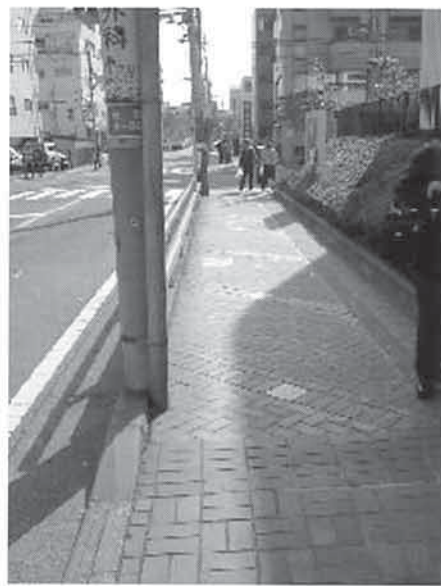
図 1 7 縁石に電柱と防護柵 を設置 (世田谷区梅ヶ丘周辺)
