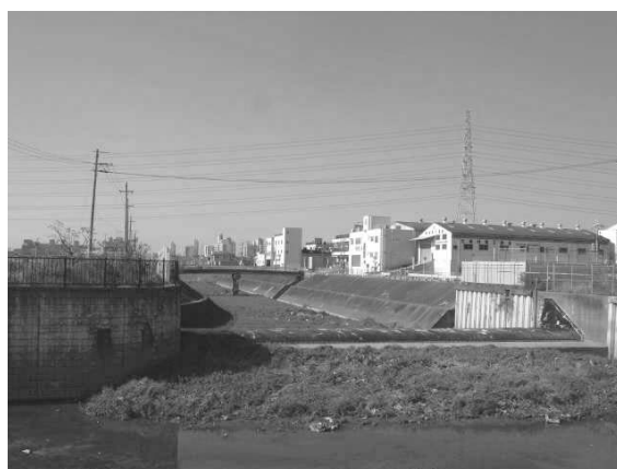
第二寝屋川最上流 珍しいエアバック式可動堰で恩智川と縁が切れてます。
