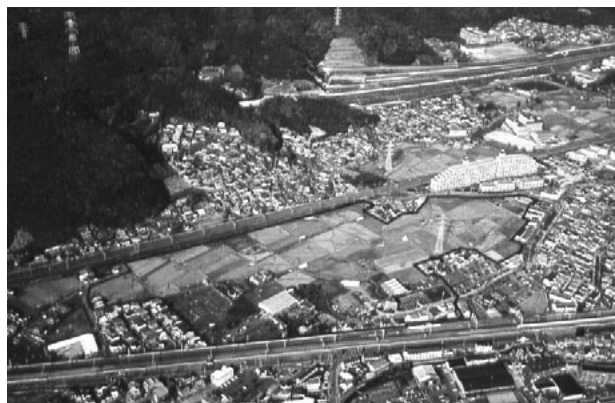
事業施行前の上牧駅付近の写真 (中央部を中心に農地が見られる)
