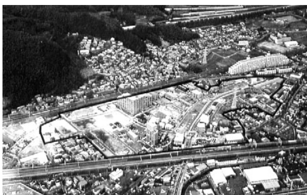
事業完了後の上牧駅付近
