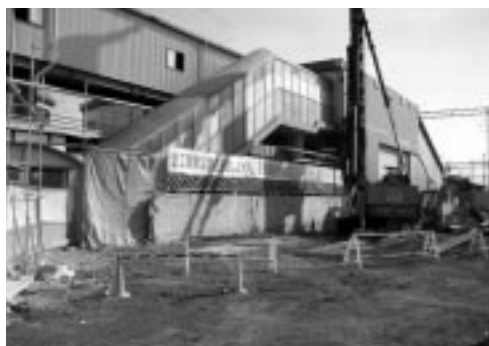
工事着手された羽衣駅
