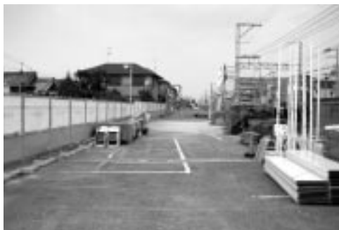
工事を待つ西側仮線用地
