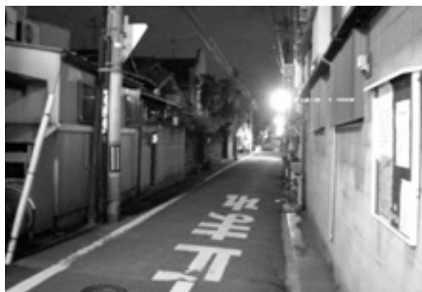
LED防犯灯設置後
