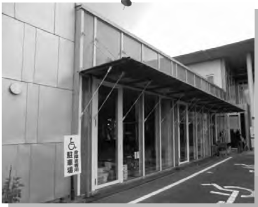
既存躯体の外側に設けられたサッシ
