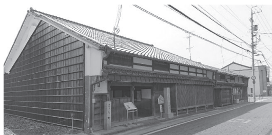
谷川土清旧宅
