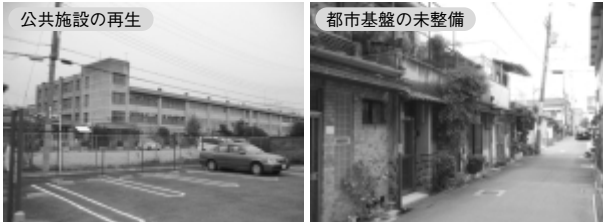
図② 中町地区の状況
