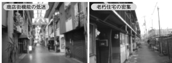
図③ 幸福町・垣内町地区の状況
