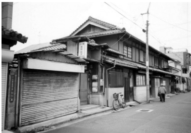
2階建長屋の外観の改修の例。
